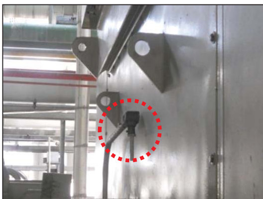
รูปที่ 2-16 อุปกรณ์ตรวจจับความร้อน
