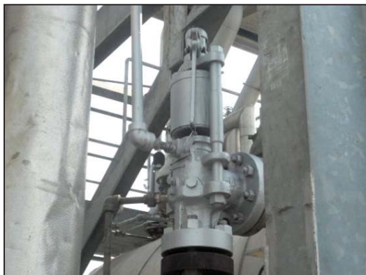
รูปที่ 2-26 ลีนินรภัยบริเวณท่อ Steam ของหม้อไอน้ำ
