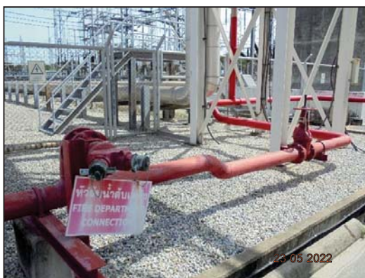
หัวฉีดน้ำดับเพลิง และตู้สายน้ำดับเพลิง รูปที่ 2-21 อุปกรณ์ดับเพลิงตามมาตรฐานสากล
