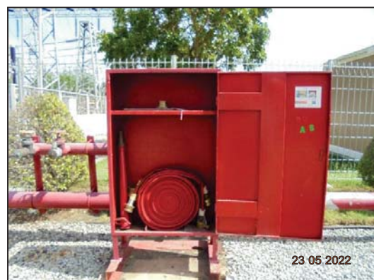
หัวฉีดน้ำดับเพลิง และตู้สายน้ำดับเพลิง รูปที่ 2-21 อุปกรณ์ดับเพลิงตามมาตรฐานสากล
